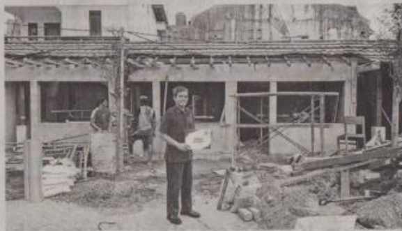
Ketua Koperasi Desa Merah Putih Sinduadi, Kliwon Suherman, memantau proses pembangunan gedung koperasi di Kantor Kalurahan Sinduadi, Kapanewon Mlati, Sleman, Rabu (11/6).
