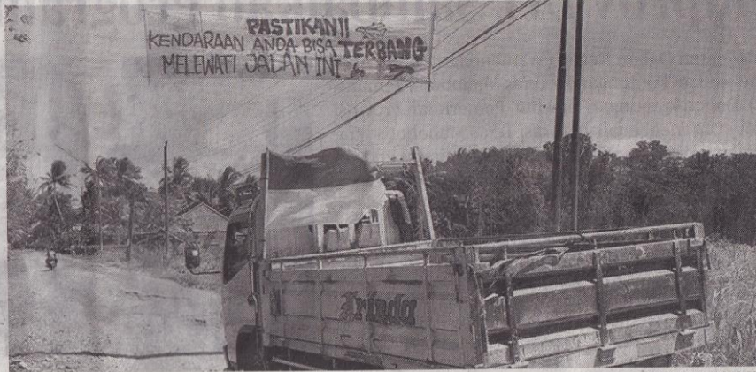
RUSAK: Jalan Cerme Demangan dilalui pengguna jalan dengan kecepatan pelan menghindari lubang.
