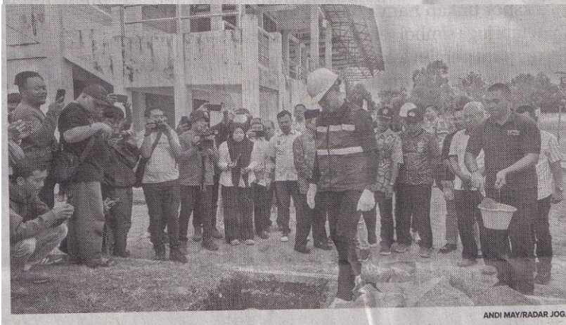
DIKEBUT: Bupati Gunungkidul Sunaryanta saat menghadiri groundbreaking renovasi Stadion Gelora Handayani.
